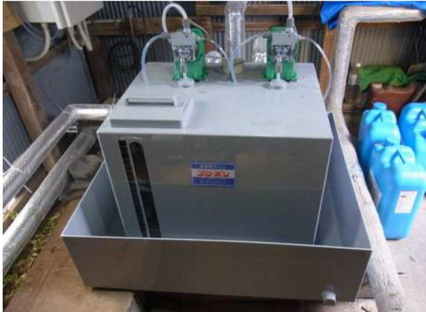
これにより、安定的な吸水と塩素注入が行われ、水の使用量と塩素の使用量が安定・削減される見込みです。
